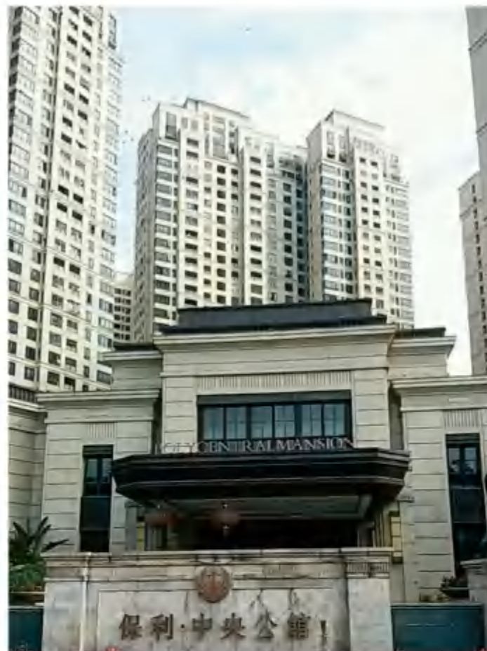
保利·中央公馆供水应用
