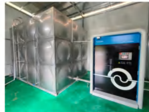
广州对口帮扶清远农村供水提质提标改造工程-伍屋塆村
