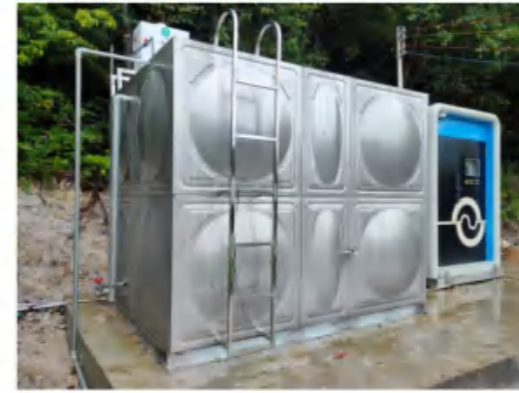
广州对口帮扶清远农村供水提质提标改造工程-岭头塘村
