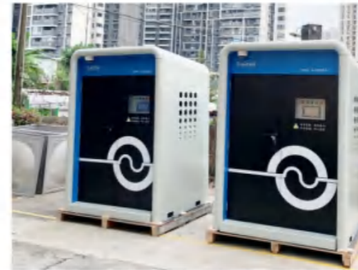
广州对口帮扶清远农村供水提质提标改造工程-梅子勿村
